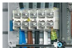
Terminali za napajanje u dodatnoj opremi
