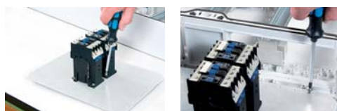
Ugradnja uređaja na montažne ploče
