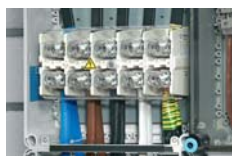
Terminali za napajanje u dodatnoj opremi
