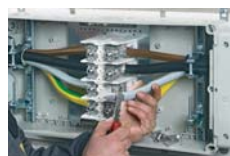
Krajevi kabla moraju pažljivo, pomoću strugača da se očiste od oksidnog sloja.
