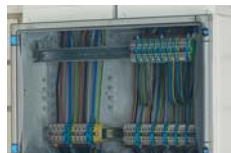
Terminali za napajanje u dodatnoj opremi
