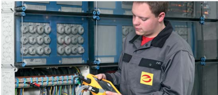
Energetski razdelnici do 630 A kao kombinacija energetskih sklopnih uređaja (PSC) prema normi IEC 61439 Dio 2
