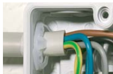
Uvođenje i izvođenje kablova pomoću prstena za kablove.
