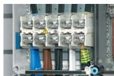
Terminali za napajanje u dodatnoj opremi
