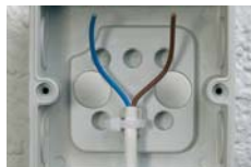
Pričvršćivanje kablova za leđa (dno) razvodničkog kućišta.
